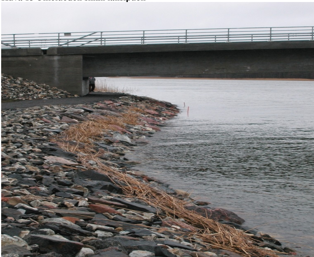
Kuva 15 Ulkoluodon sillan länsipuoli
