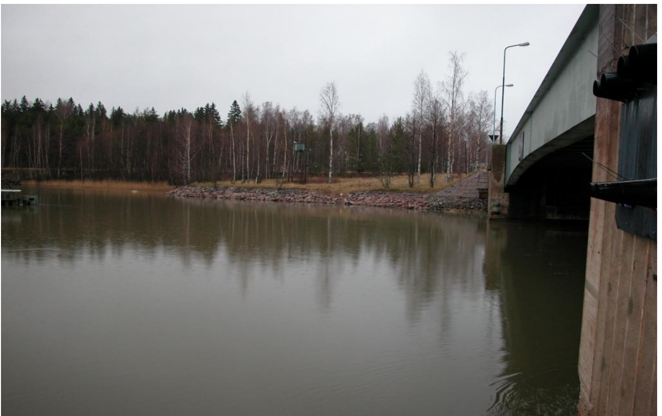
Kuva 6 Kanavan pohjoispuoli - kuva Perniöön päin. Jyrkkä pengeri vaatisi laiturirakenteita. Omistaja Suomen Valtio / Tiehallinto.
